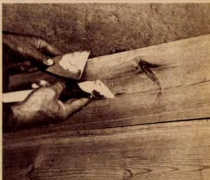
Ha két kittkést használunk, egyikkel tisztántarthatjuk a másikat
